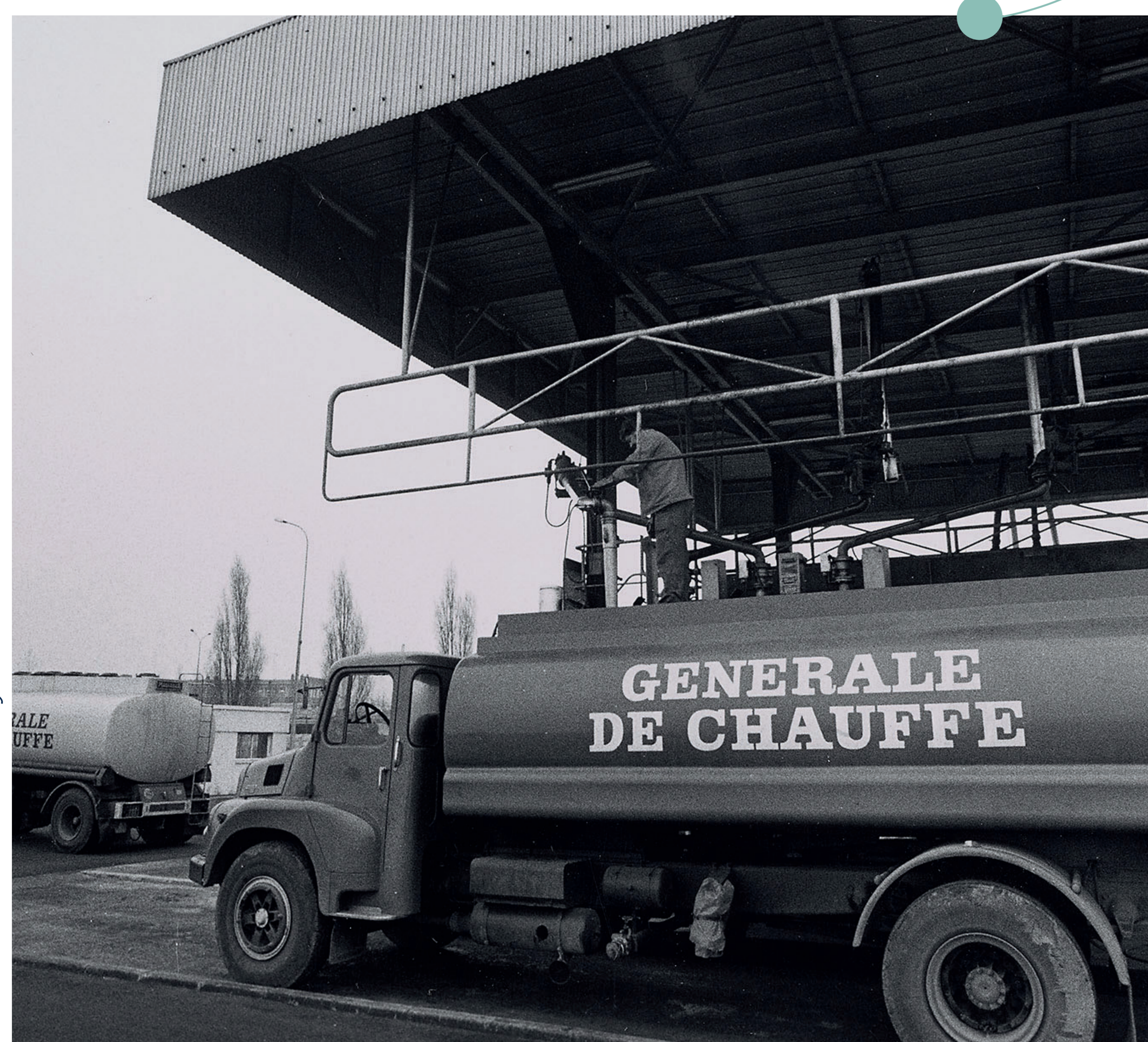
The Société Générale de Chauffage at work.
